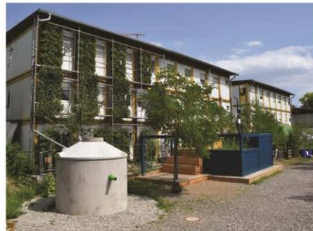
Abb. 46: Das Projekt „INTERESS-I“ in Stuttgart mit Fassadenbegrünung und Brauchwassernutzung. Quelle: BuGG
